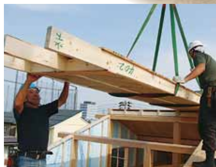
パネル施工中の住宅
